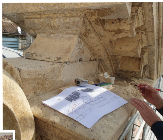
Examen des pierres du fronton à remplacer ou à reconstituer
