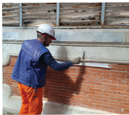
Remplacement des briques et reconstitution des pierres du soubassement abîmé
