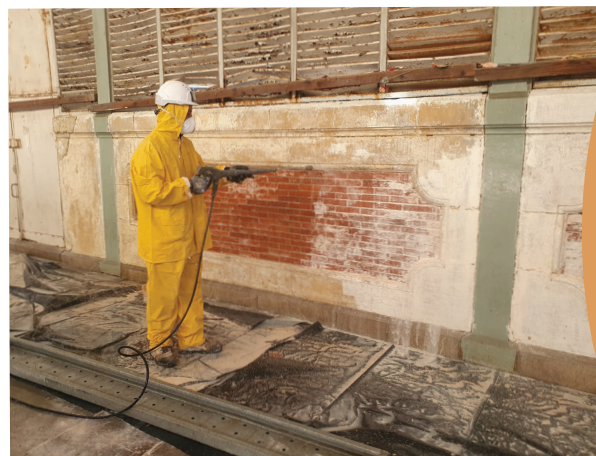
Travaux de décapage des anciens badigeons
