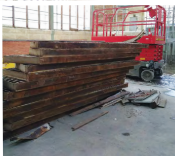
Caissons des anciennes persiennes déposés
