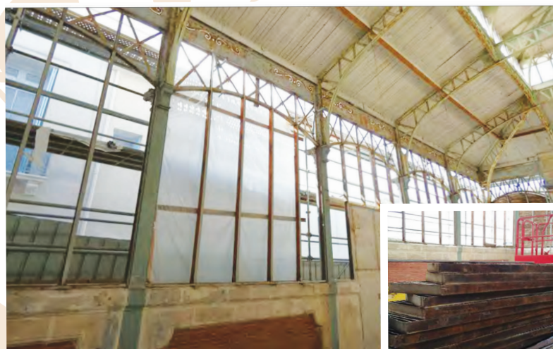
Dépose des persiennes endommagées pour réfection à l'identique
